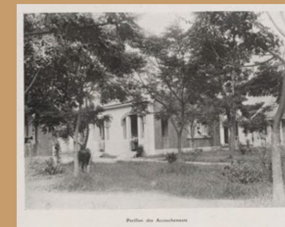
Tòa nhà hộ sinh Obstetrics building
